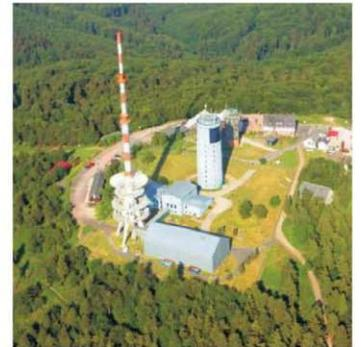
• Bis zum Bau einer neuen 126 m hohen Sendeantenne mit Sendergebäude im Jahr 1974 wurden vom runden Turm UKW- und Fernsehsendungen ausgestrahlt. Nach der Fertigstellung der neuen Sendeanlage wurde der Gittermast auf dem 43 m hohen Turm demontiert.
